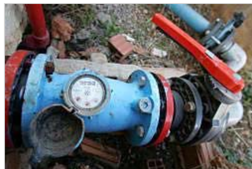
Contador de agua y válvulas de control a la salida de un pozo.
